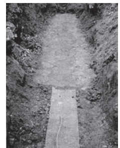
帯状電極 ホクデンEP-1敷設
