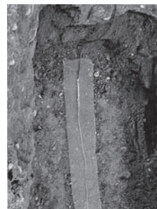
帯状電極 パワーメッシュと裸電線敷設
